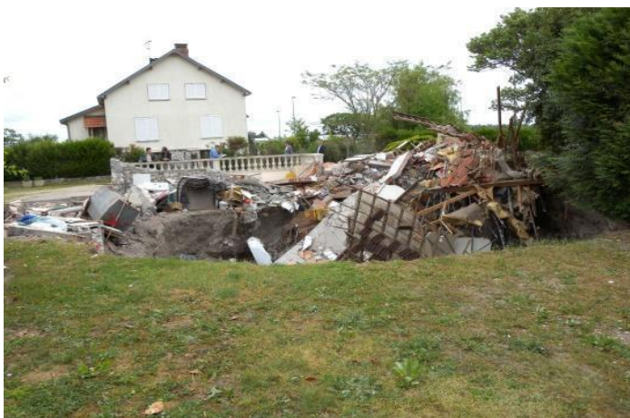
Maison effondrée à St-Pryvé St-Mesmin en 2010 - © DDT 45
